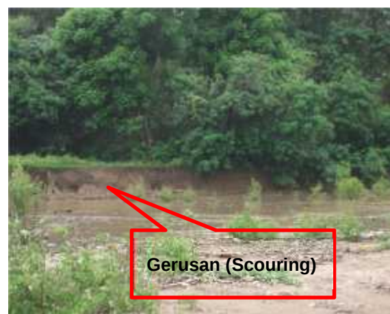
Gambar 4.3. Gerusan lahan warga Sumber : Dokumentasi, 2017
