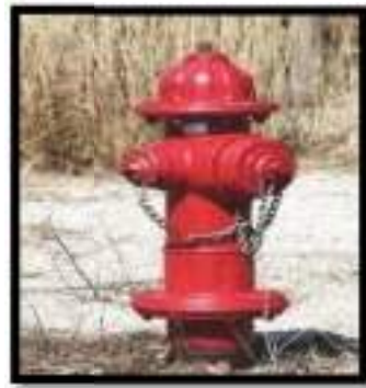
Gambar 5.30, Gambar system pemadam kebakaran
