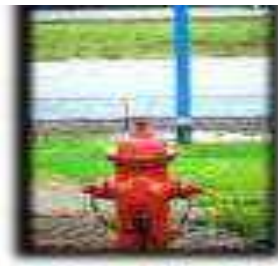
Gambar : 5.34. Hidrant halaman
