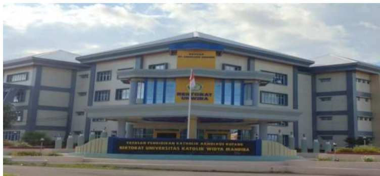
Gambar 4.3. Gedung Rektorat UNWIRA Kupang (Dokumentasi Pribadi, Maret 2022)
