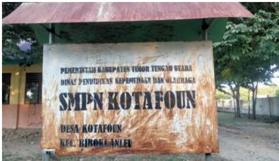
Gambar 4.1 Bangunan Gedung SMPN Kotafoun, TTU (Dokumen Pricilia)
