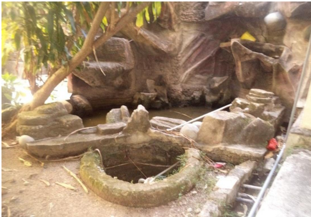
Gambar 1.6. Kondisi eksisting sumur (Dokumentasi, 2015)
