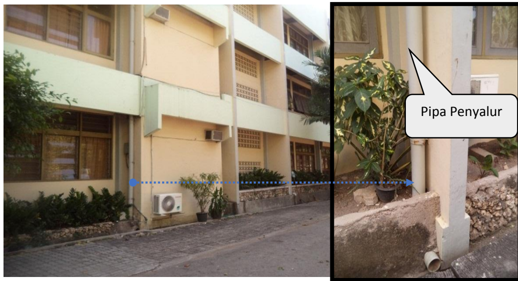
Gambar 1.2. Proses penyaluran air hujan dari atap ke saluran (Dokumentasi, 2015)
