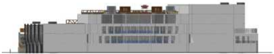
Gambar 5. 28 Tampak samping bangunan
