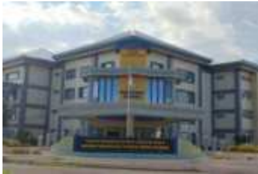
Gambar 4.3. Gedung Rektorat UNWIRA Kupang (Dokumentasi Pribadi, Maret 2022)
