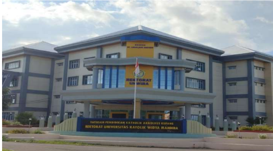
Gambar 4.4. Gedung Rektorat UNWIRA Kupang (Dokumentasi Pribadi, Maret 2022)
