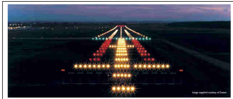
Gambar 5.6 Sistem Pencahayaan Pada Landasan
