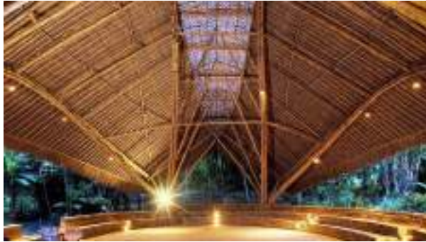
Gambar 54. Rangka atap bambu
