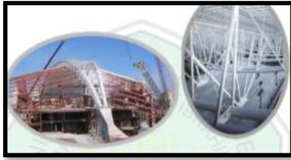
Gambar V.27 Konsep Struktur Rangka Ruang (space frame)
