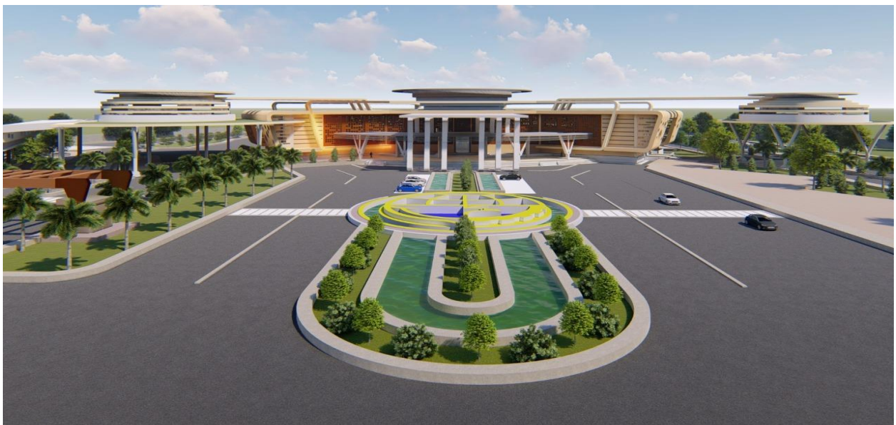
Gambar : 78, Tampak Depan Bangunan.
