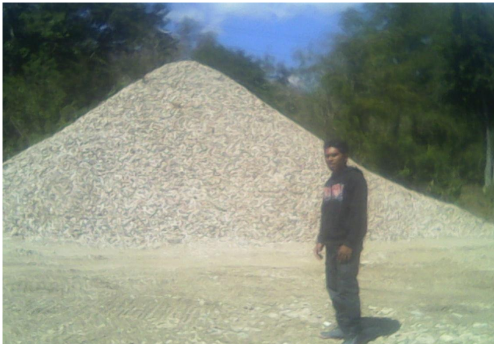
Gambar 1.2. Penumpukan material Batu Pecah kali Noemuti
