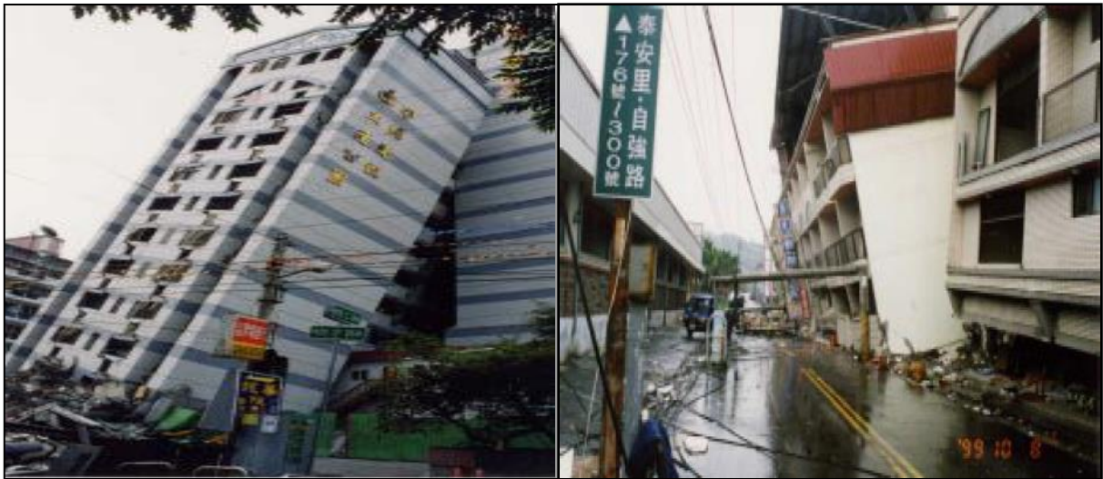
Gambar 2.37. Kerusakan Pada Bangunan Karena Soft Storey Pada Lantai Dasar (22)
