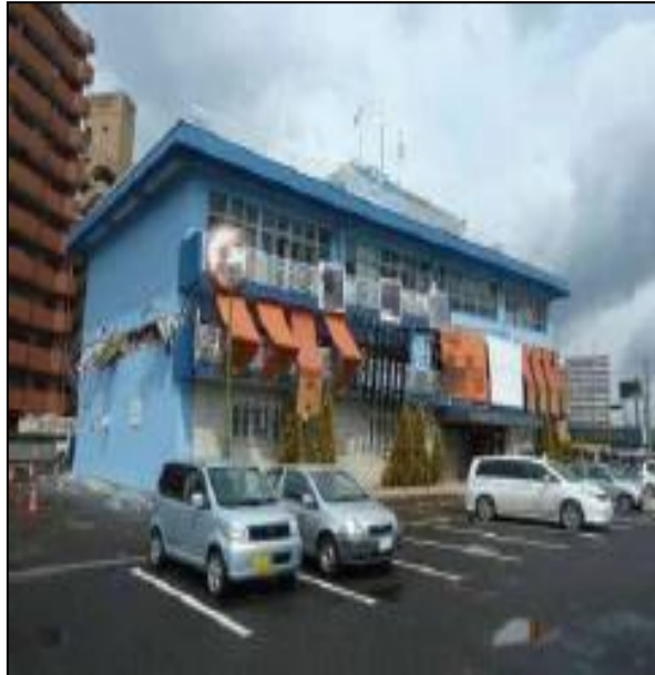
Gambar 2.38. Kerusakan Pada Bangunan Karena Soft Storey Pada Lantai Tengah, Gempa Tohoku, Jepang (19)
