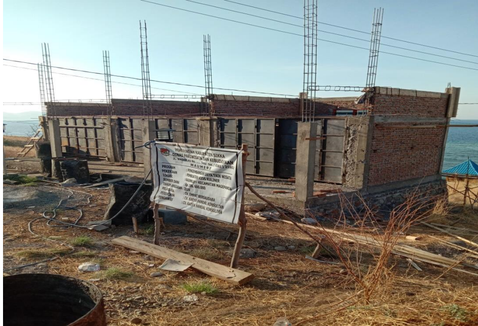
Gambar 5.5 Kios Kuliner/Warung masih dalam tahap pembangunan. 14
