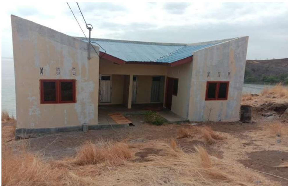
Gambar 4.4 Toilet dan Kamar ganti di Lokasi Wisata Pantai Tanjung Kajuwulu yang disediakan Oleh Dinas Pariwisata dan Kebudayaan Kabupaten Sikka. 19
