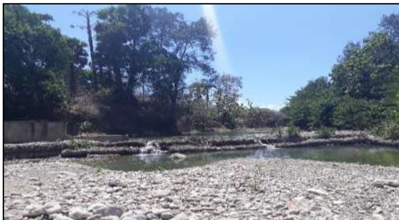
Gambar 3.1 Kondisi Bendung Kleja 1
