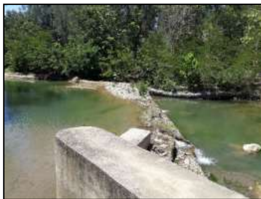
Gambar 1.3 Kondisi Bangunan Utama Bendung Kleja 1
