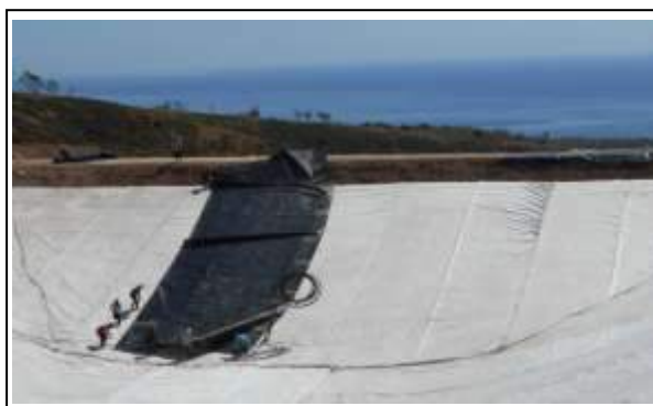
Gambar 4.14 : Pemasangan Geombrane
