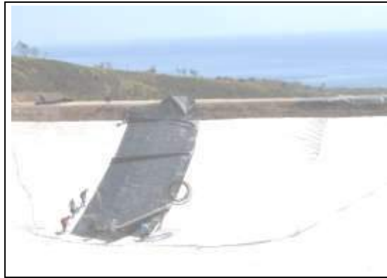
Gambar 2.9. Pemasangan Geomembran
