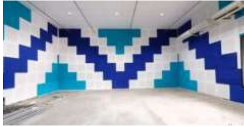
Gambar 4.45 Unit akustik siap pakai yang berlubang dan bercelah (Sumber: http://www.acoustics.com/product )
