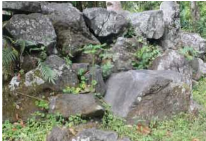
Batu-Batu Besar Yang Digunakan Dalam Pemasangan Ngadu
