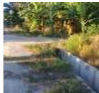
Gambar 3. 10 Drainase Sekitar Lokasi
