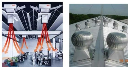
Gambar 5.25 HVAC dan Turbin Ventilator
