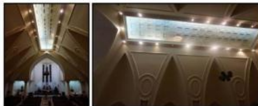
Gambar 4.54 Penggunaan lampu TL pada Langit-langit Gereja Sumber Gambar : E-jurnal UNSRAT Pencahayaan Buatan Dalam Gereja Katolik
