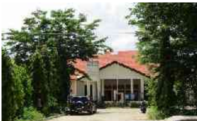
Gambar 4.5 Kampus III UNWIRA Kupang, FISIP
