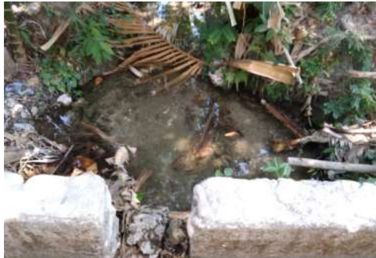
Gambar 4. 6 Contoh Gambar Lubang Pada Saluran Sekunder
