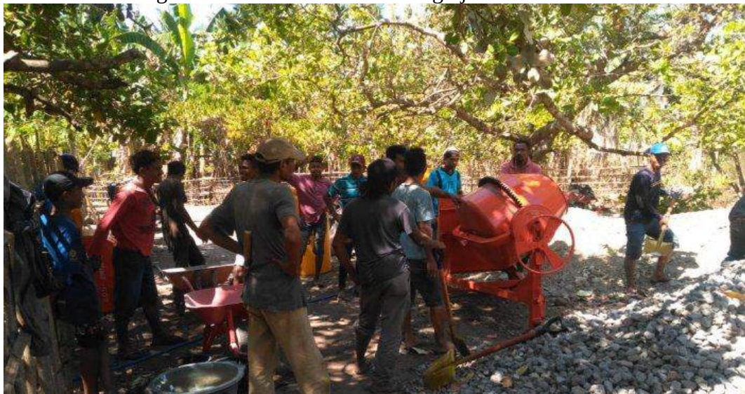
Gambar 5.4 Warga Dusun Reli Sementara Mengerjakan Rabat Beton
