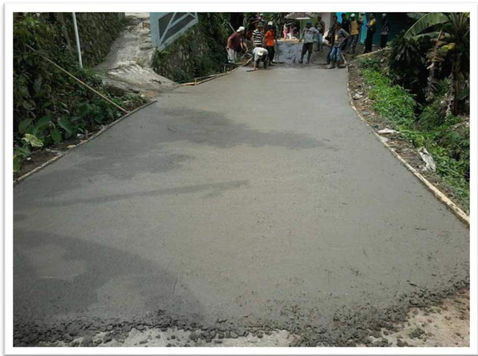
Gambar 4.1 Pembangunan Rabat Beton di Dusun Reli
