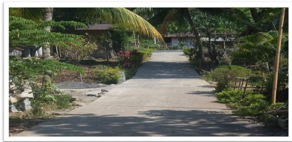
Gambar 4.8 Pembangunan Rabat Beton di lorong 1V Dusun Waekoe
