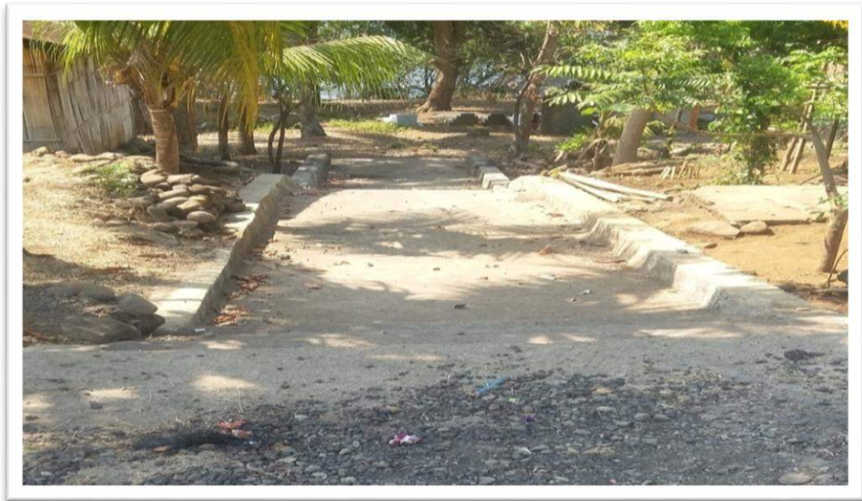
Gambar 4.7 Pembangunan Rabat Beton di lorong 111 Dusun Basalai
