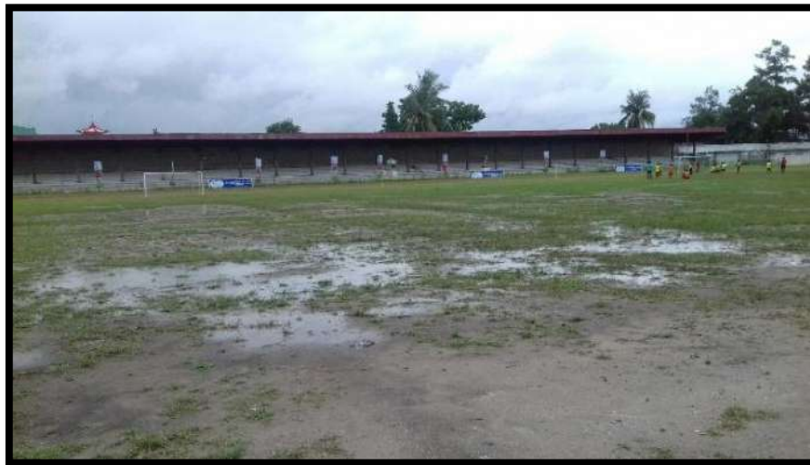
Gambar 1.1 Kondisi Lapangan Sepak Bola Batunirwala Setelah Hujan Berhenti
