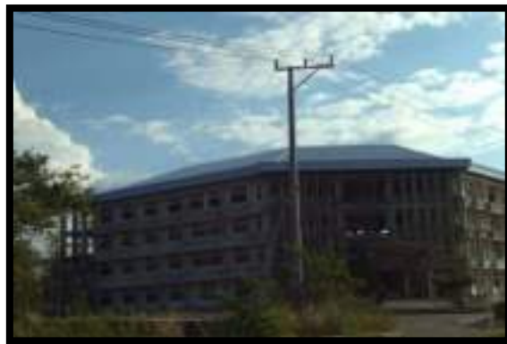
Gambar 23 : Jaringan Listrik pada lokasi perencanaan
