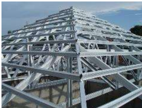
Gambar 5.15 Rangka Baja Ringan
