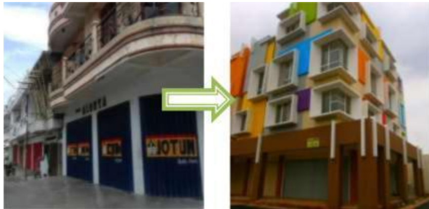
Gambar 72 : Peningkatan lantai bangunan
