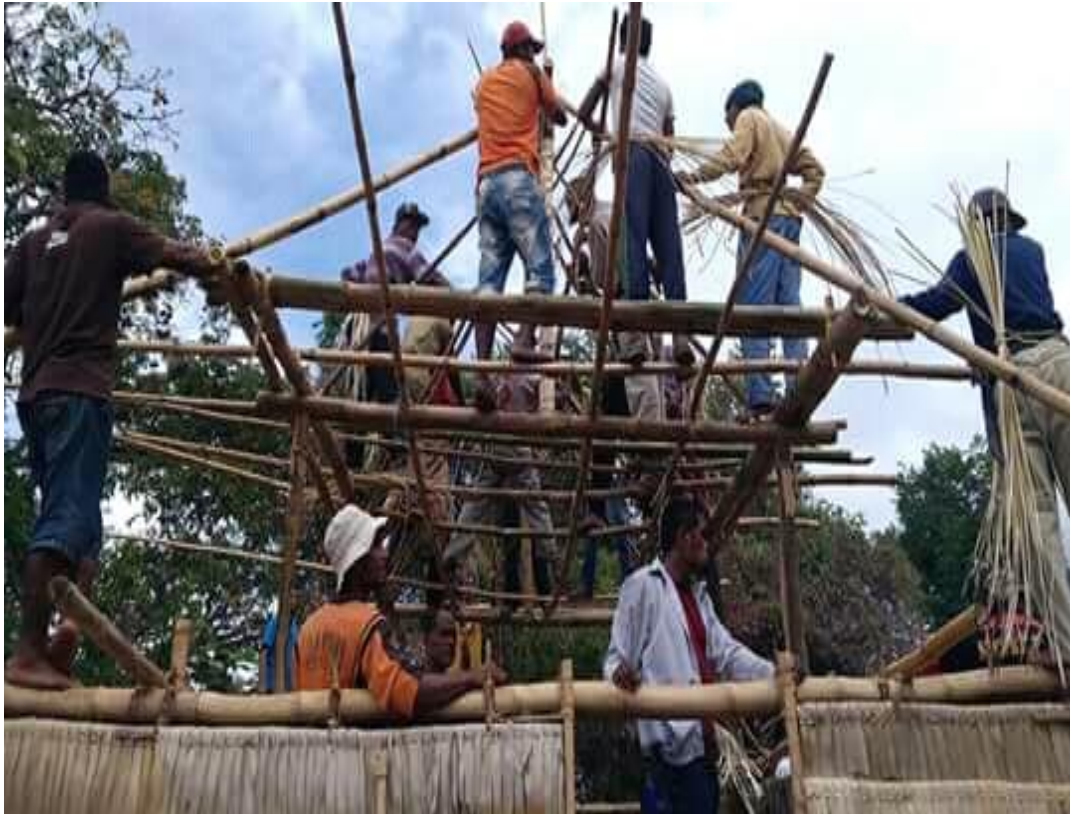
Gbr. 11. Pemasangan Wola Gere. Dokumentasi: Wendel Wotan, 2017
