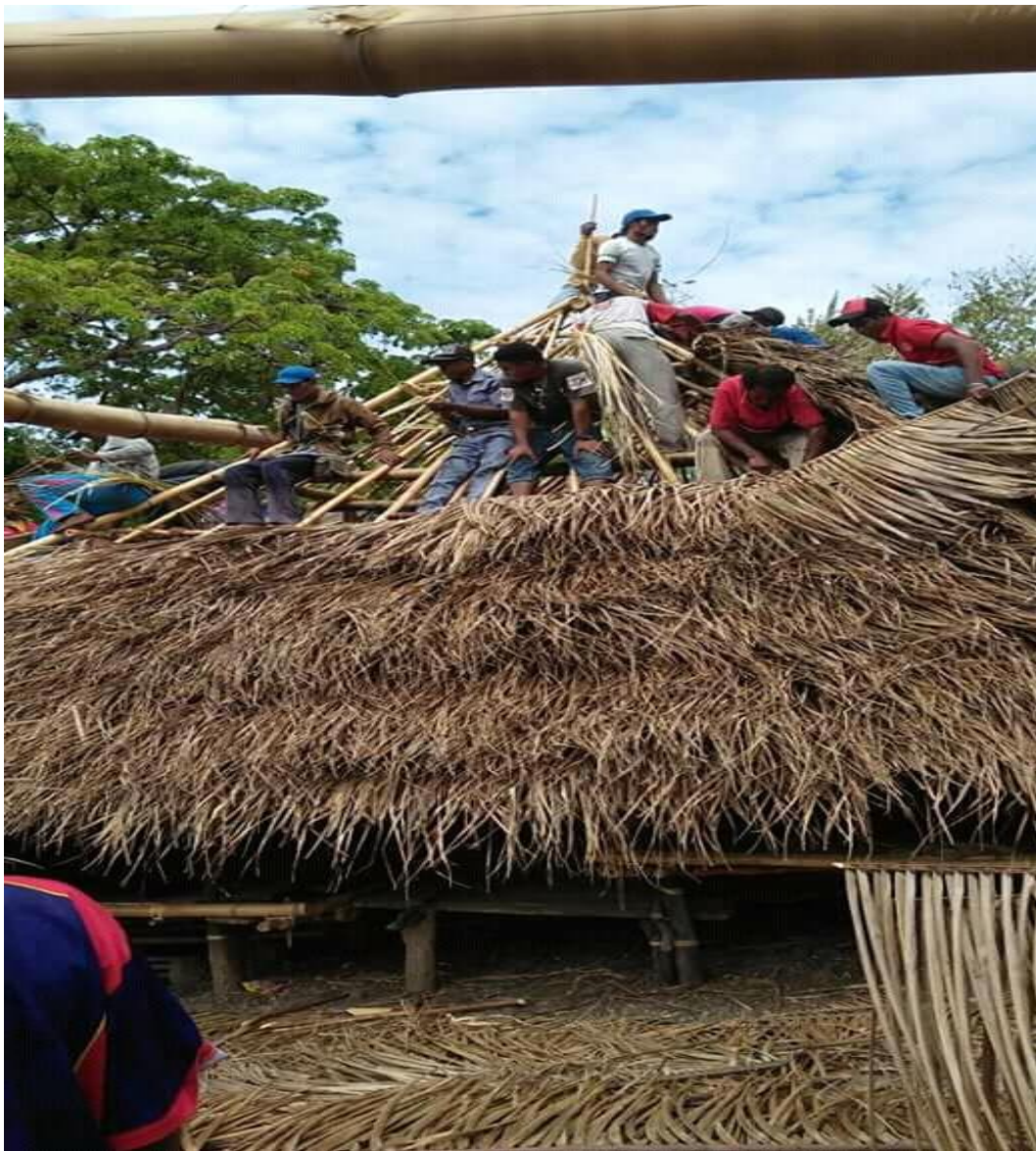
Gbr. 12. Take Lango. Proses pengatapan rumah adat suku Kabelen Ikun . Dokumentasi: Wendel Wotan, 2017
