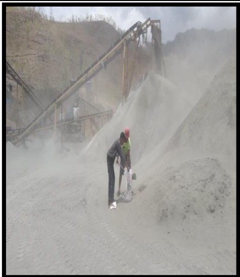
Gambar 1.3 Pengambilan Material Di Quarry Sumber : Dokumentasi
