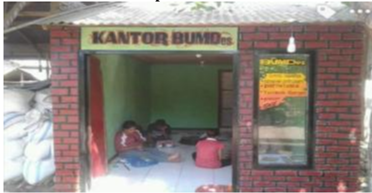
Gambar 5.3 22 Bangunan BUMDes di Desa pledo Kecamatan Witihamo Kabupaten Flores Timur.
