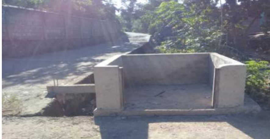
Gambar 5.12 53 Pembangunan Bak Sampah RT di Desa Pledo Kecamatan Witihama Kabupaten Flores Timur
