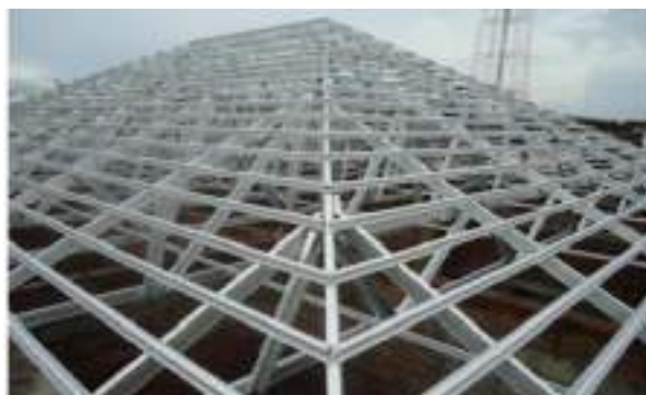
Gambar 5.35 Konsep struktur atap baja ringan Sumber: Konsep desain penulis
