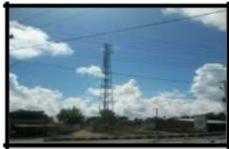
Gambar 19. Tower Sumber : Dokumentasi Pribadi
