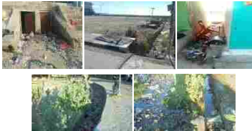
Gambar 42. pembuangan sampah di saluran drainase.
