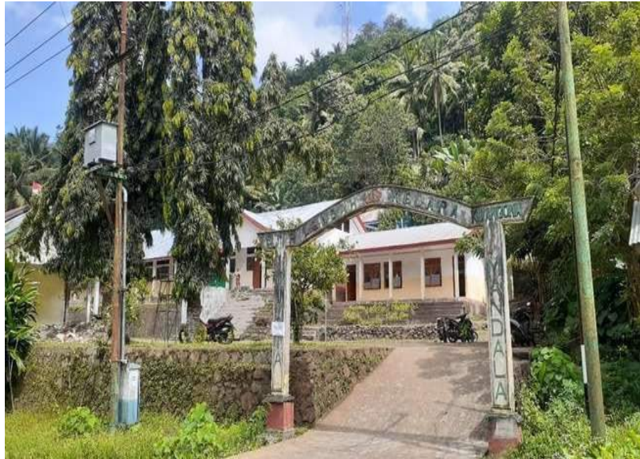
Gambar 4.1 Gedung SMPS Lembah Kelapa Kiwangona (Dokumentasi Pribadi, Mei 2023 )
