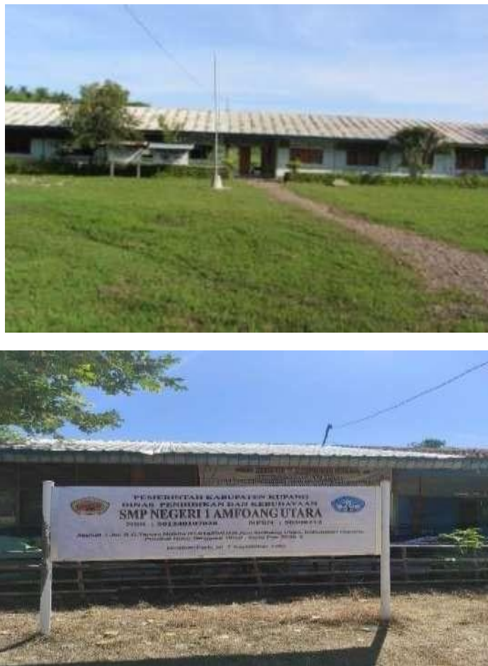
Gambar 4.1. selasa, 05, 2023. Bangunan Gedung SMPN 1 Amfoang utara
