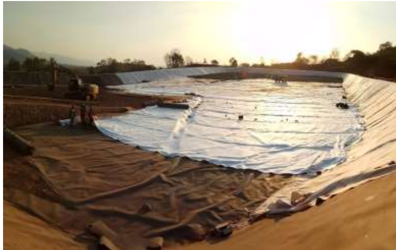
Gambar 2. 3 Lapisan Geomembran dan Geotekstil TPA Larantuka
