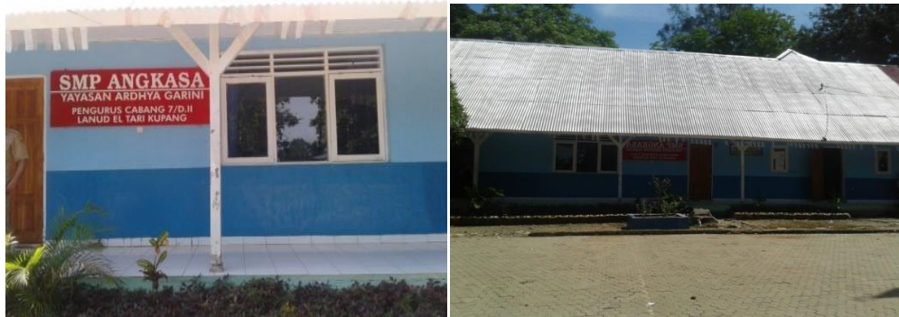
Gambar 4.1 : Gedung SMP Angkasa Penfui Kupang
