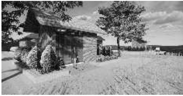
Tampilan Rumah Pompa
