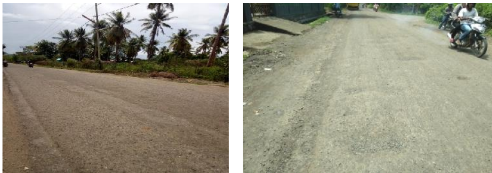
Gambar 1.1. Kondisi perkerasan pada ruas jalan Tujuh Maret dan Trans Nagawutun
