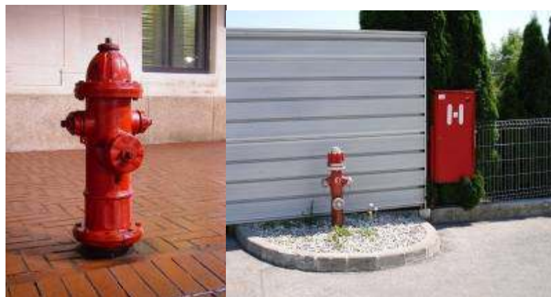
Gambar 5.24 : Hidrant Halaman
