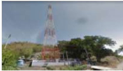
Gambar 5. 13 Tower/menara Telekomunikasi Selular Pada Sekitar Lokasi
