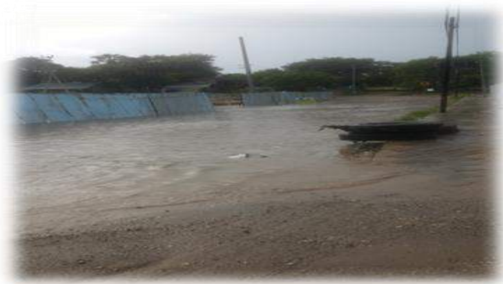
Gambar 1.1 Genangan Air pada Jalan Adi Sucipto Tenau Kupang
